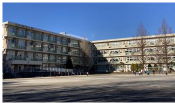
■ 鶴川第二小学校 (築48年)
