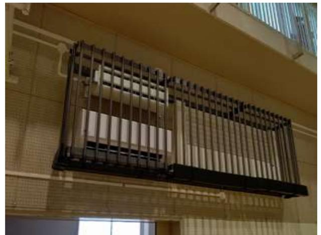
この方式は、壁輻射パネルの温度が、熱エネルギーとして周囲に直接伝わるため、冷房時は実際の室温よりも体感温度を下げ、暖房時は足下まで暖くなる効果があり、児童・生徒が日常的に使用する体育館下部を中心に効率的な冷暖房を行っています。
