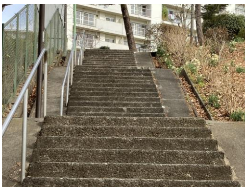
② 2-2 東側歩道 (階段)
