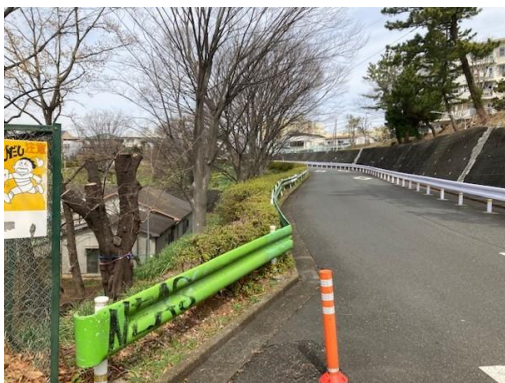
⑤ 5-1 北側歩道
