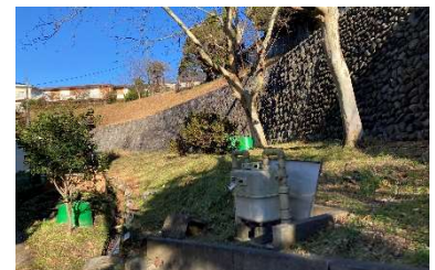
【敷地周囲の急な傾斜】
