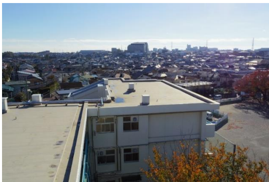
(屋上防水改修) 東棟校舎はシート防水にて改修
