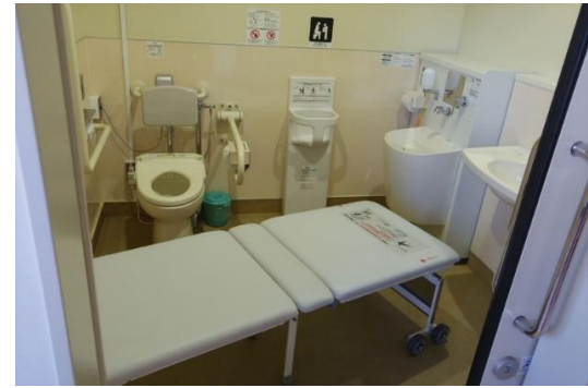
(トイレ改修工事) 2階の教材室をだれでもトイレに改修
