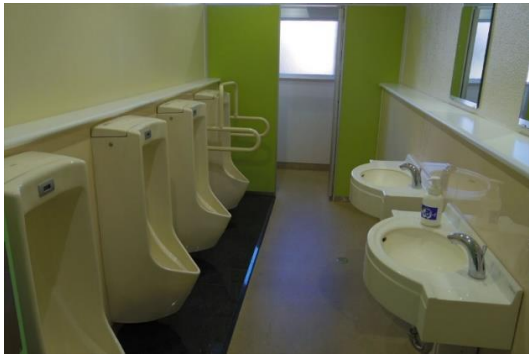
(トイレ改修工事)ドライ化
