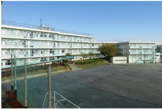
(校舎南側全景)
