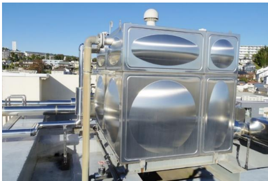
(給水設備の改修)水槽・配管類の更新
