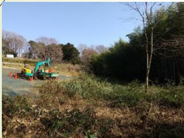
2022年度工事の様子
