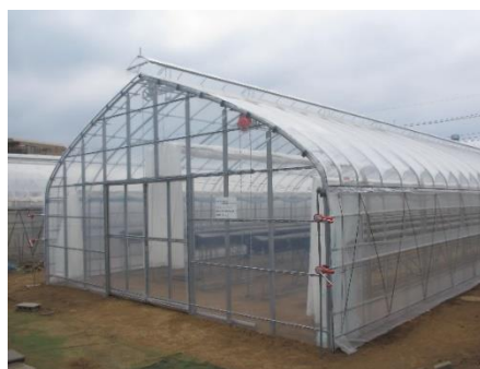
都市農業活性化支援事業整備施設
