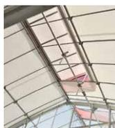
ハウスの天井部分。自動で開閉し、太陽光や外気を取り込みます
