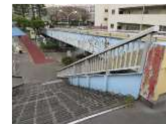
山崎団地歩道橋
