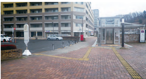
▲多摩境駅前広場のエレベーター
