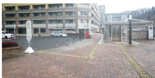
▲ 多摩境駅前広場のエレベーター
