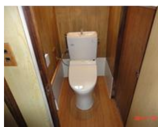
【改修後】 洋式便器に交換し、段差を解消
