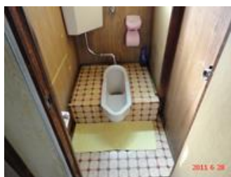
【改修前】 段のある和式便器
