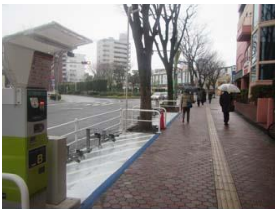
◆ 2016年3月に供用を開始した成瀬駅北口路上自転車駐車場
