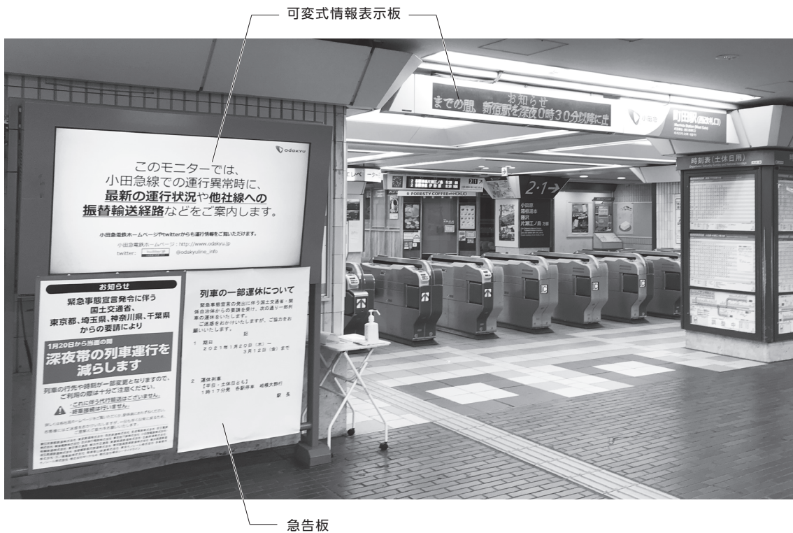
【写真14.2】 可変式情報表示板の配置例
