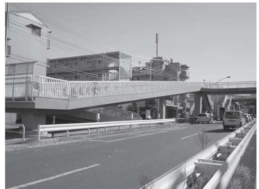
【写真10.1】 スロープの設置例
