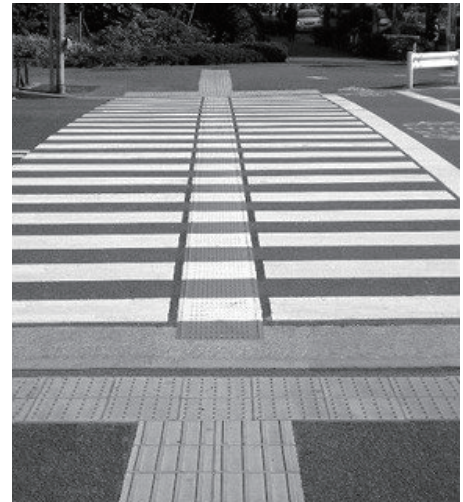
【写真8.1】 エスコートゾーンの設置例
