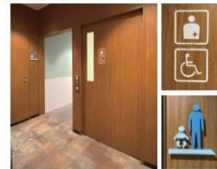
・便所設備(機能)の分散配置を示した表示 全ての障害者を対象とした国際シンボルマークとオストメイト用設備のピクトグラム表示のみ
