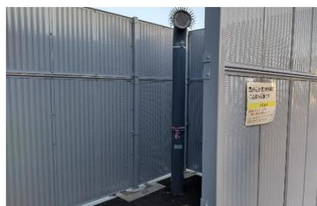
写真7 ガス抜き管
