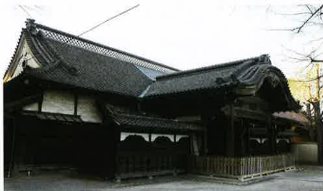
図1 「浅草寺伝法院」玄関・客殿(修理前)
