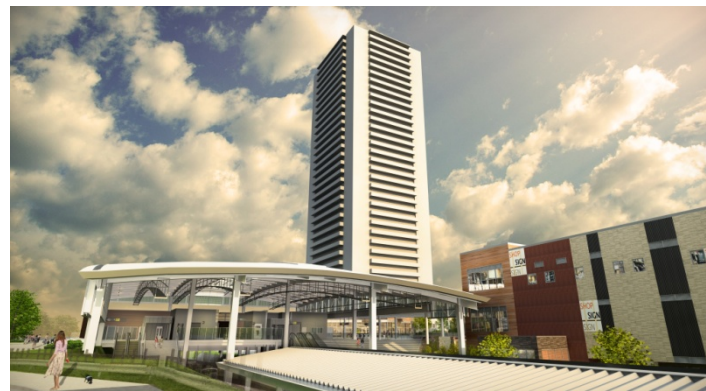
▲ 駅施設越しに見る住宅イメージ
