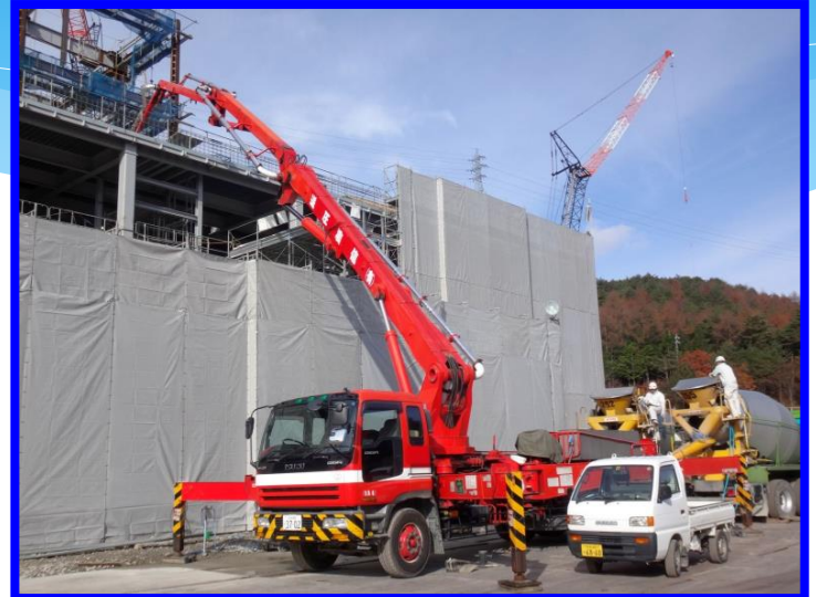
コンクリート工事
