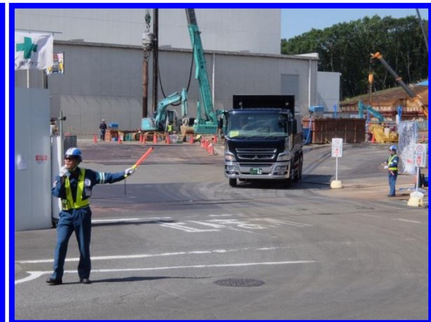
工事車両 誘導状況
