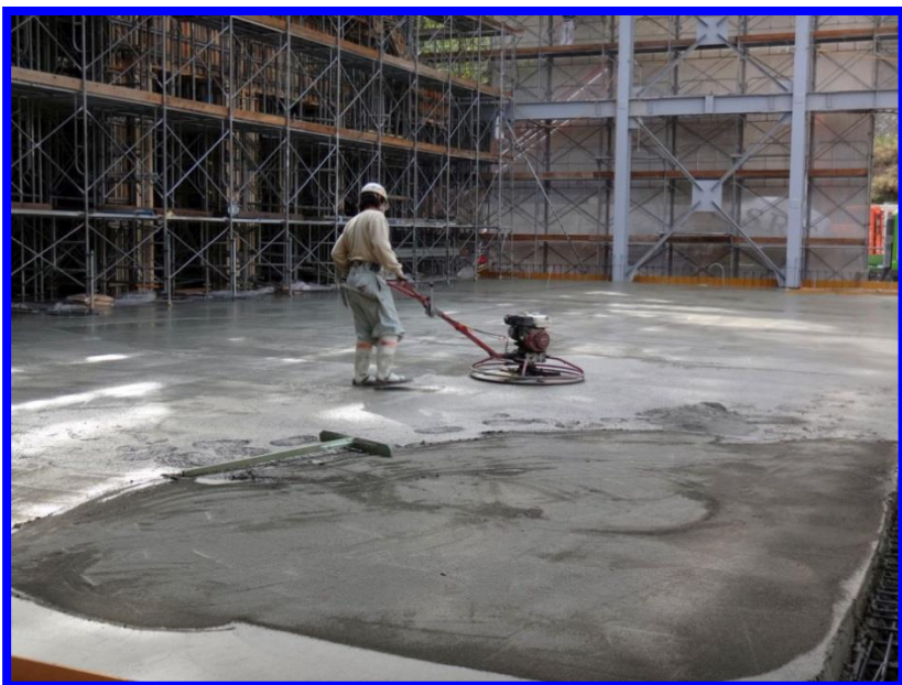
コンクリート打設後 こて仕上げ作業
