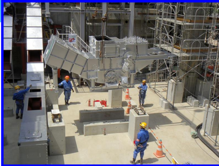
機器据付工事
