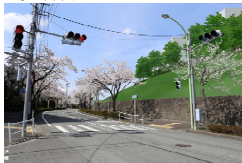
工事の完了後
