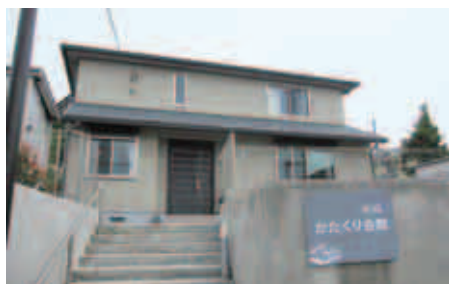
軽量鉄骨造2階建て、延床面積179.84㎡の施設です
