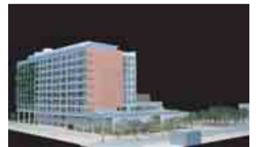
北東側より見る
