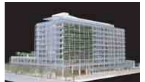
南側より見る
