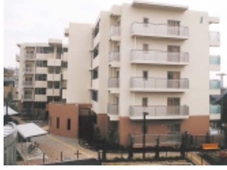
新設された真光寺市営住宅
