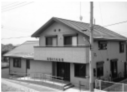
完成した馬場さくら会館
