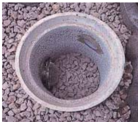
雨水浸透ます
