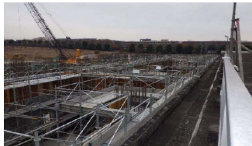
鶴見川クリーンセンター水処理施設増設工事
