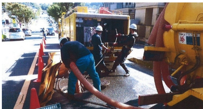
下水道管の清掃作業
