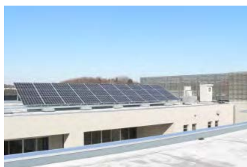
太陽光発電システム
