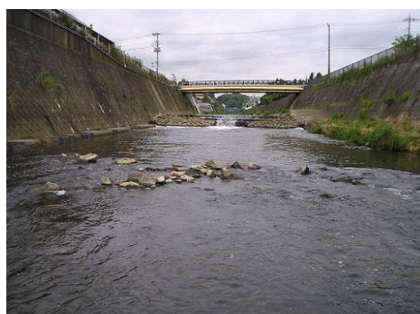
鶴見川(麻生橋付近)
