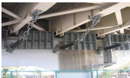
耐震補強工事の状況
