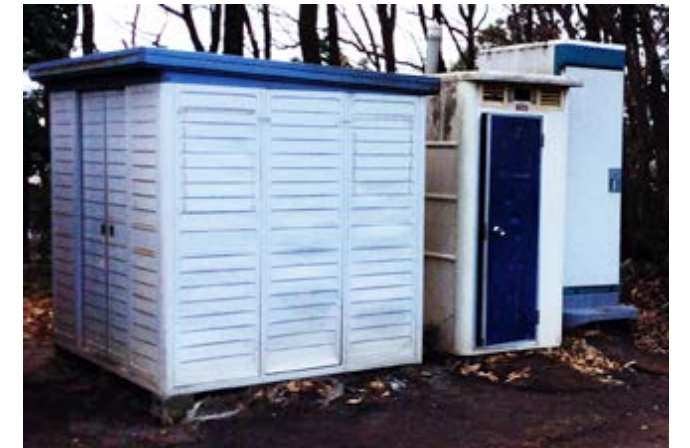
(上写真)スポーツ広場利用状況 (右上写真)スポーツ広場管理状況 (右下写真)倉庫・簡易トイレ設置状況 (※建築基準法や衛生上課題有)
