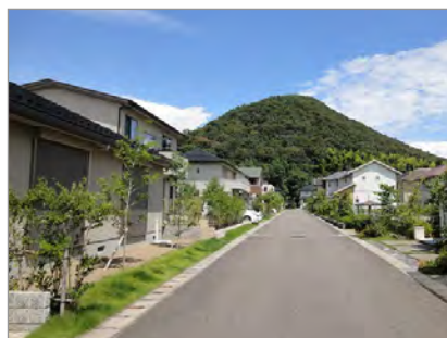
●周囲の環境に合わせ、壁面の色彩や屋根の形状などに配慮が見られるまち並み（岐阜県各務ヶ原市）
