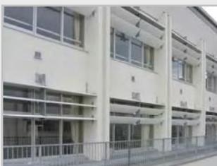
■窓面に設けられたシンプルな形状の可変式ルーバーは、建築物の形態意匠に馴染みつつ、直射日光を遮っています(愛知県北名古屋市)
