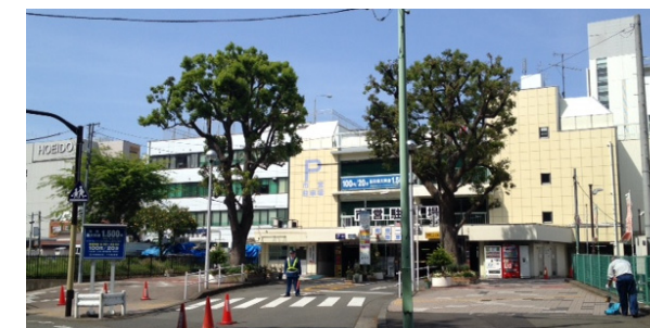
現状の市営駐車場
