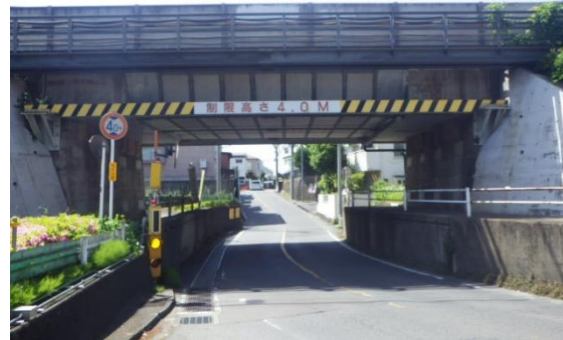
現道状況写真（南大谷ガード下）
