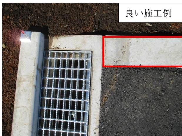
特殊 L U 形溝工が終端まで設置され、特殊 L U 形溝工の間に境石が設置されている。
