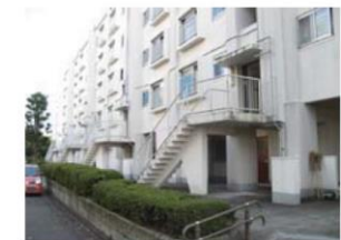
エレベータの無い住宅棟
