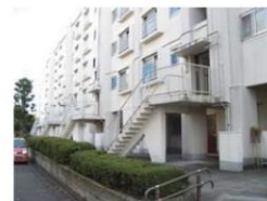
エレベータの無い住宅棟
