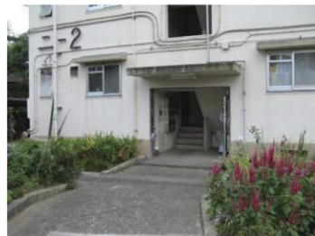
5階建てでエレベータの無い住宅棟
