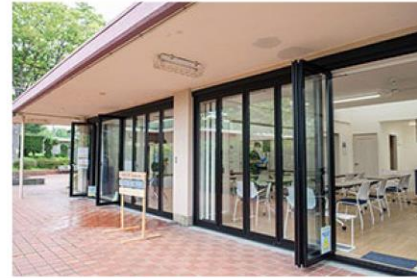
①集会所の改修(まちやまテラス)
