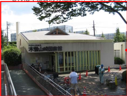
～センター地区の公共施設～ 利用ニーズが多く、狭隘化している
