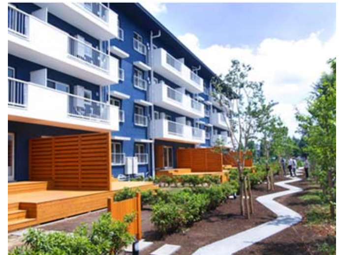
③住棟の様子(改修後)
