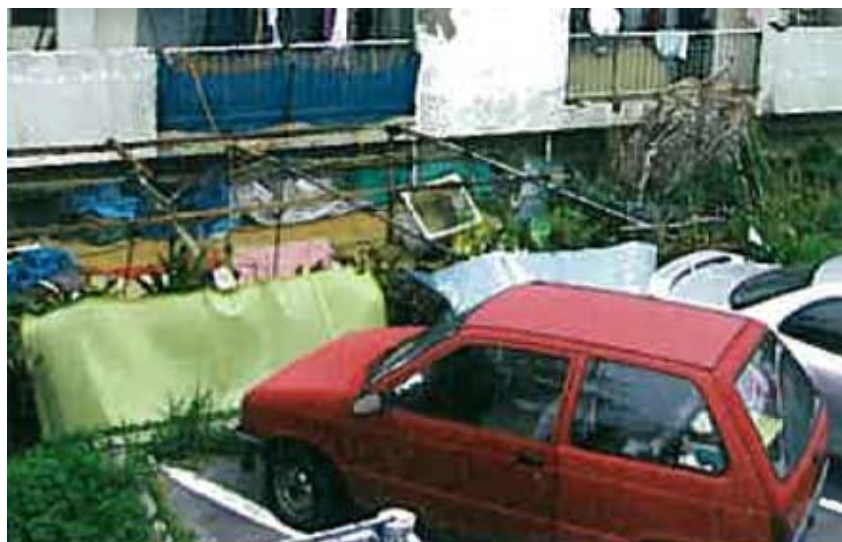
②ごみの不法投棄・放置(住棟の緑地)
