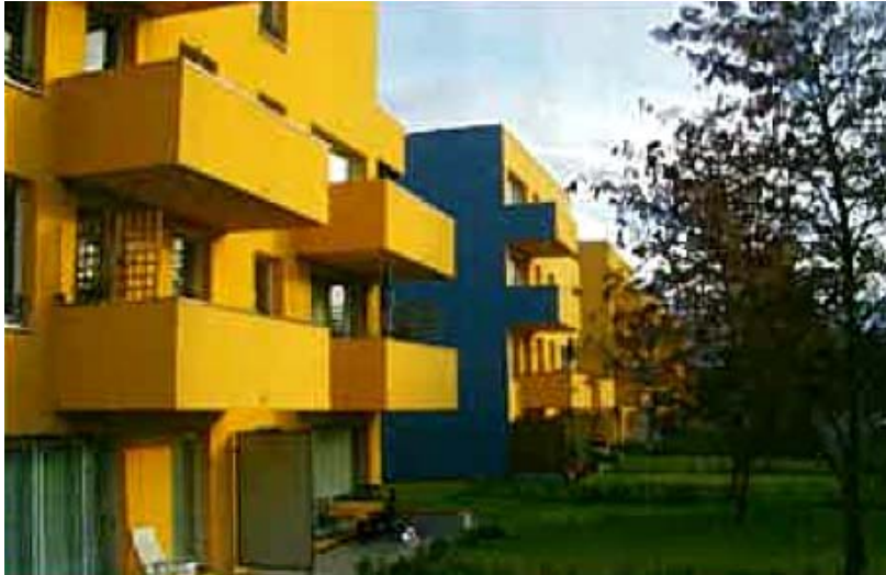
①-1 団地を一部減築して再生した事例。 1階部分の緑地は専用庭。 (ドイツ ライネフェルデ)
