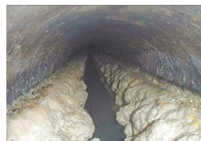
油が詰まった下水道管の実際の写真です！
