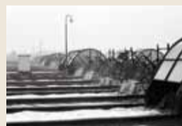
三河島処理場 (写真提供・東京都下水道局)
