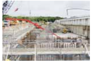
増設工事の写真
