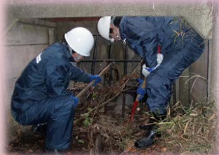
水路のスクリーン（柵）清掃。ごみ等を取り除かないと浸水の原因になる。
