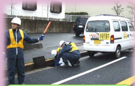
集水ます（排水管を合流させたり、泥などで管が詰らないように泥だまりの役割をする）の清掃。
