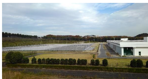
図5-2 鶴見川クリーンセンター未利用地活用の現況
