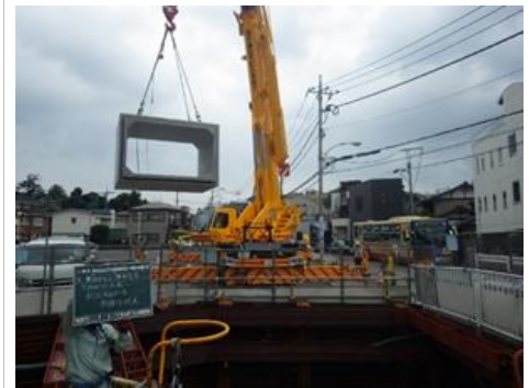
図 6-5 浸水対策として行う雨水管整備工事
