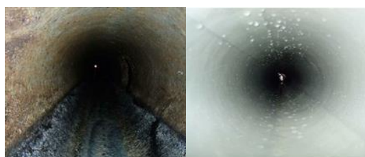
図6-8 下水道管の更生工事の写真 (写真左：更生前、写真右：更生後)
