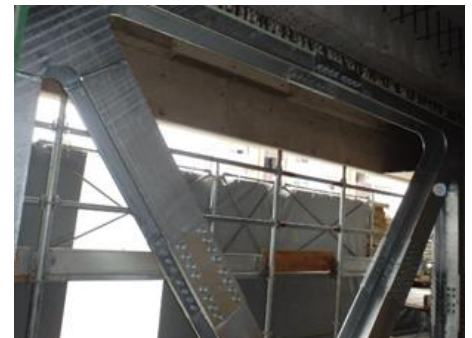
図 6-6 耐震補強工事中の建物
