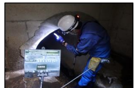
図 6-7 管渠の腐食点検
