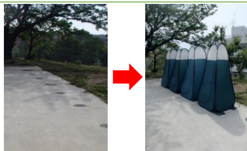
図5-6 マンホールトイレ設置の様子
