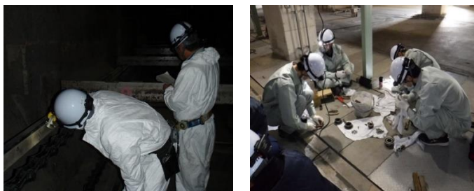
図5-4 設備の点検調査（左）・補修修繕作業（右）
