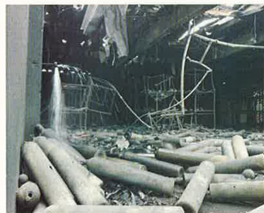
図2 鎮火後の現場
