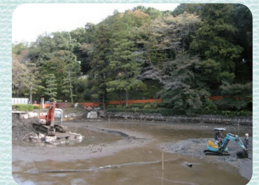
浚渫作業の様子
