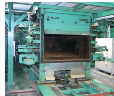
⑤ コンパクト 燃やせるごみをコンテナに押し込みます。
