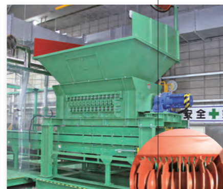
② 破袋設備 袋を破いて容器包装プラスチックを取り出します。
