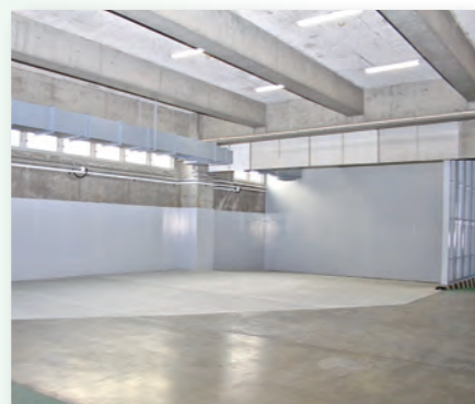
① 受入ヤード 容器包装プラスチック収集袋で搬入された容器包装プラスチックを一旦貯留します。
