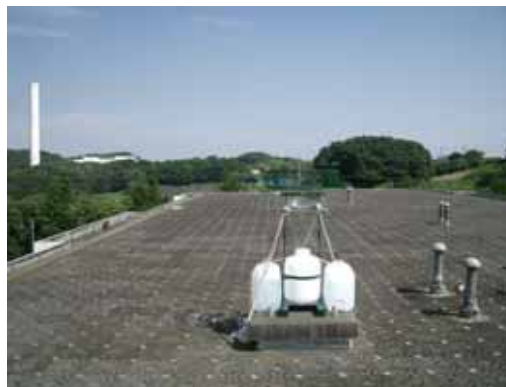
地点② 小山田桜台団地屋上
