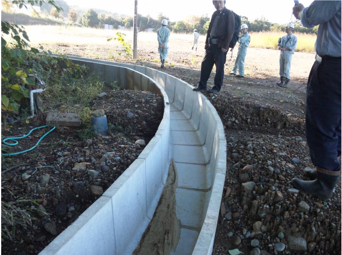
④ 階段水路 池の辺→調整池の施工状況
