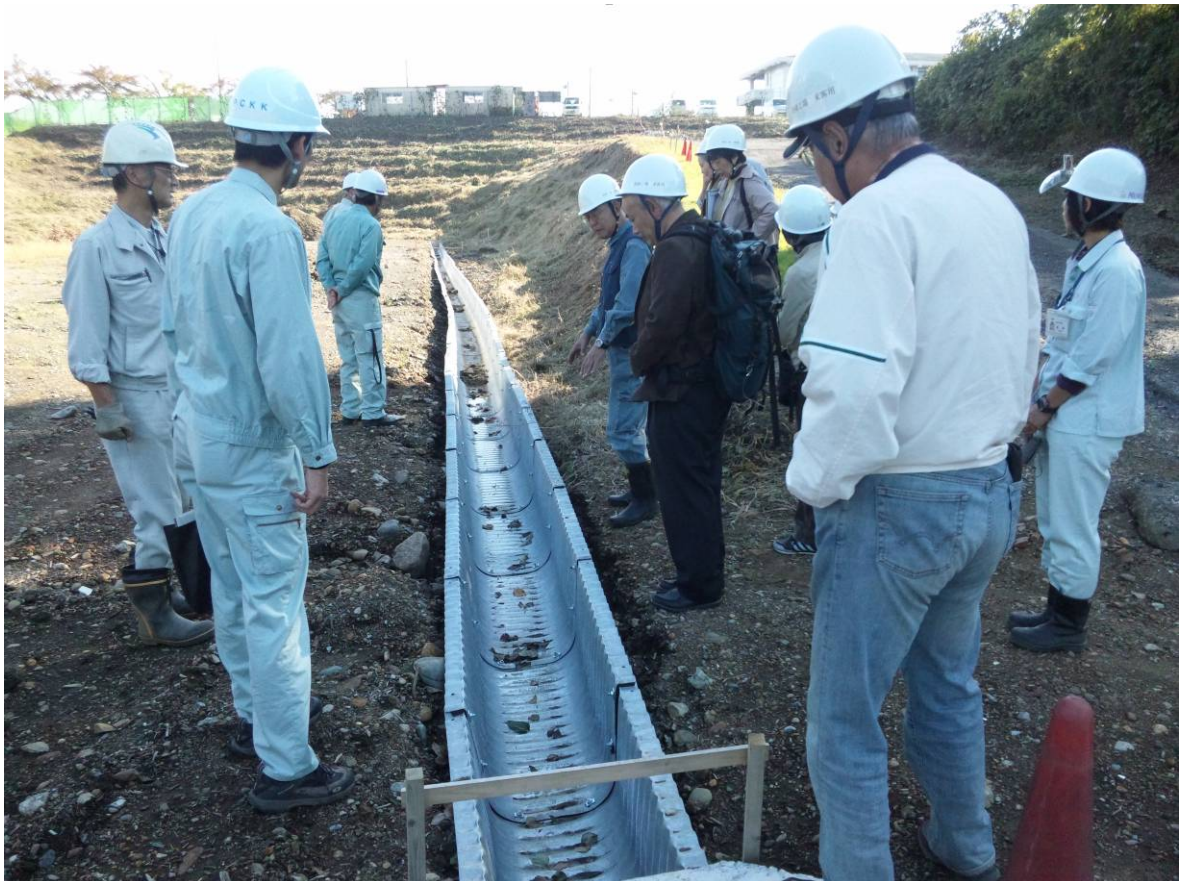
② 峠谷仮設水路（コルゲート管）の施工状況
