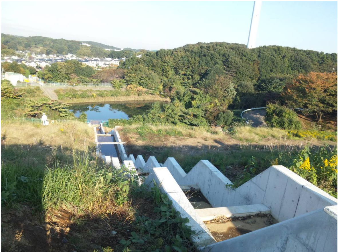
④ 階段水路 池の辺→調整池の施工状況
