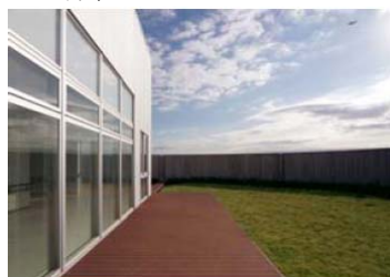
中央防波堤埋立処分場にある中防灰溶融施設における屋上緑化 （東京二十三区清掃一部事務組合）
